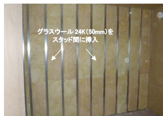
写真-3 グラスウールの挿入
