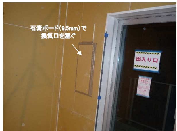
写真-5 換気口の遮音
