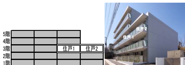
図-3 対象住戸（東側立面，北東側外観）
