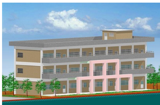
図-1 増設工法による補強外観例
