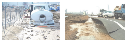
写真-1 当現場の液状化による被害状況
