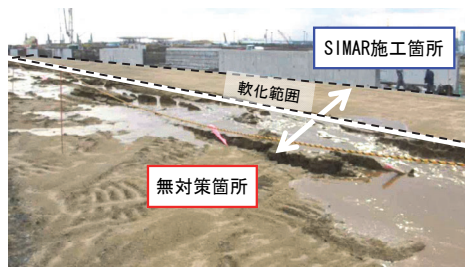
写真-4 軟化範囲の被害状況
