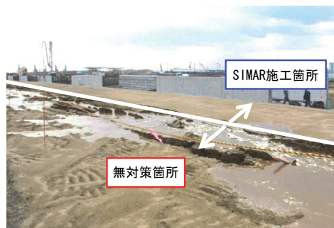
写真-2 SIMAR 工法の液状化対策効果の状況
