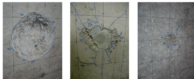
改良なし 改良厚200mm 改良厚300mm 写真-2 衝撃実験結果の例 (同じ衝突回数における衝突面の破壊状況の例)
