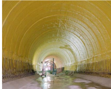
写真-2 ハイ・イータス工法による防水工の仕上がり
