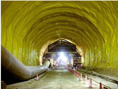
写真-1 従来工法による防水工の仕上がり
