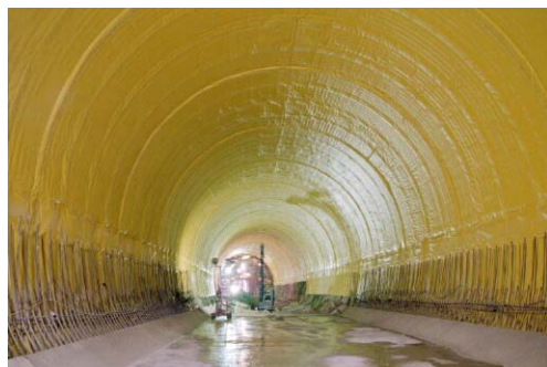
写真-2 ハイ・イータス工法の仕上がり状態
