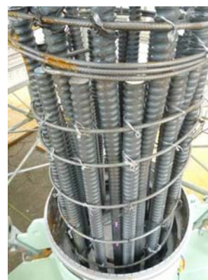
写真-1 鉄筋の挿入実験状況
