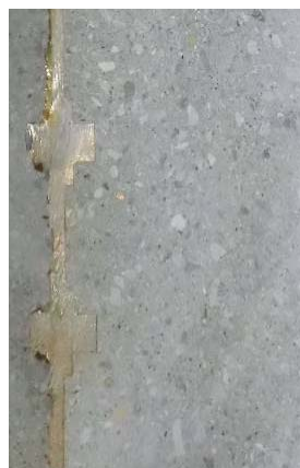
写真-3 コンクリート 充填状況 (試験体切断面)
