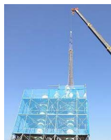
写真-1 挿入鉄筋施工状況
