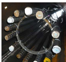
鋼管柱内部
