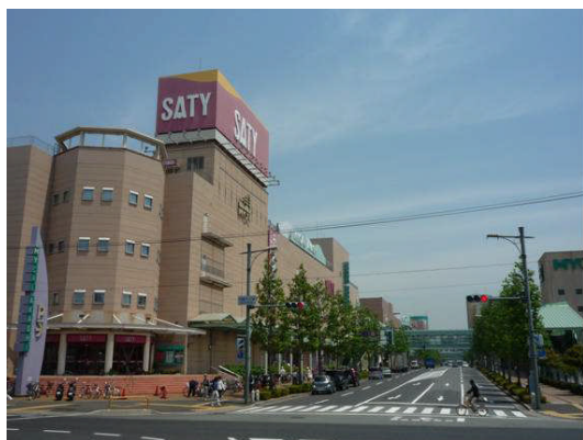
写真-1 マイカル明石店舗外観
