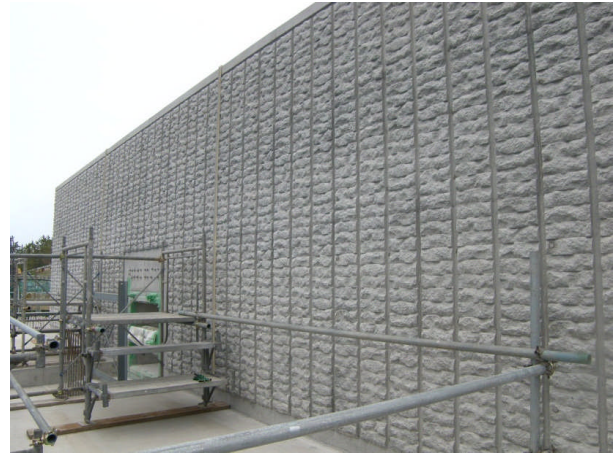
写真-2 防潮堤の外観（海岸側）
