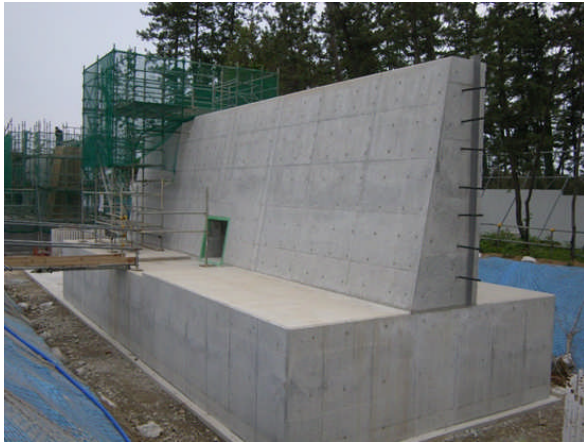
写真-1 防潮堤の外観（陸側）
