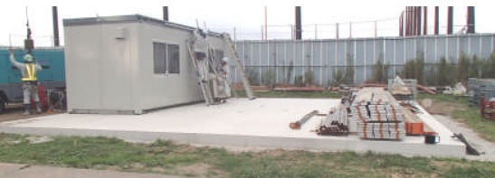
写真-2 既設宅地を模擬したべた基礎
