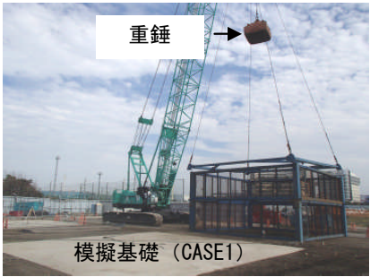
写真-5 動的載荷試験状況
