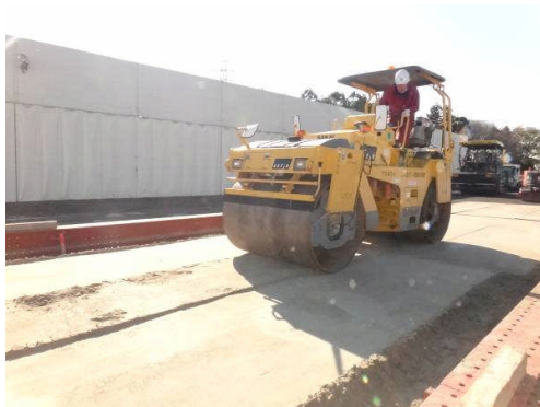
写真-2 7t 級タンデム振動ローラー
