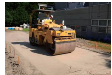
写真-2 転圧試験状況
