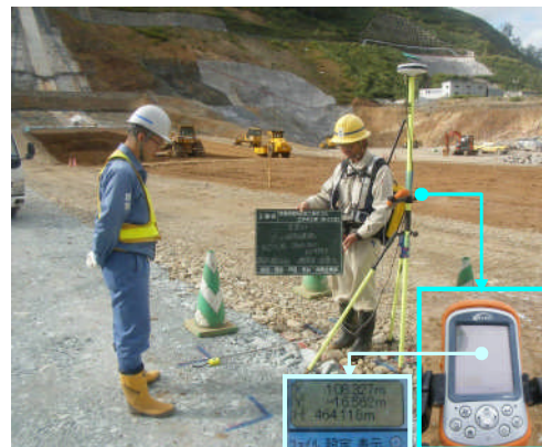
図-9 RTK GNSS 測量状況
