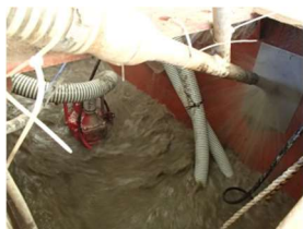
写真-5 砂洗浄状況
