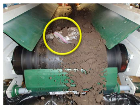
写真-18 汚染源の分別状況
