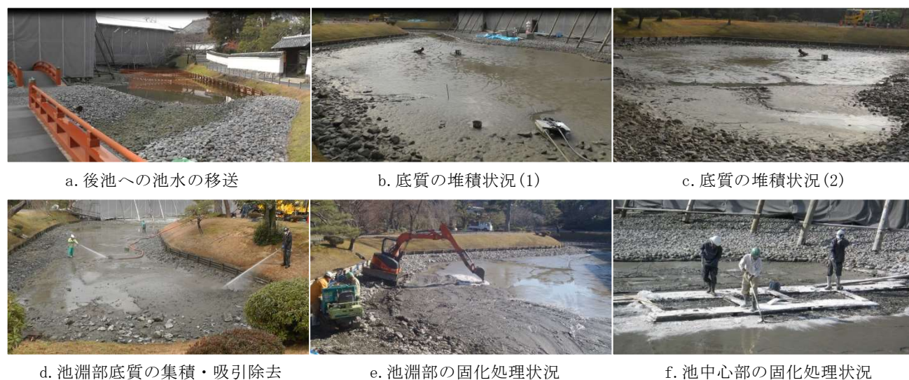
写真-2 阿字池の浄化に向けた取り組みの施工状況写真
