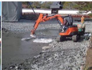
写真-2 底質安定化処理状況
