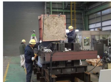
写真-4 供試体(模擬地盤)の設置
