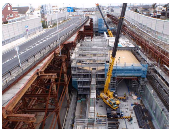
写真-1 躯体構築状況
