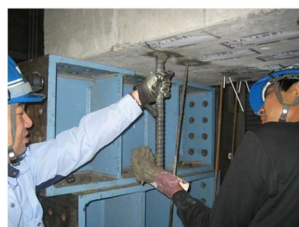
③鉄筋挿入 (上向き)
