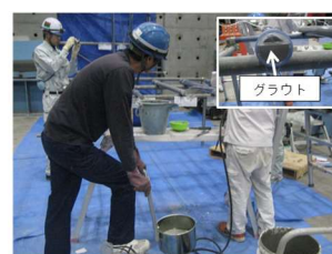
②グラウト注入
