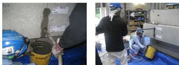
①グラウト注入
