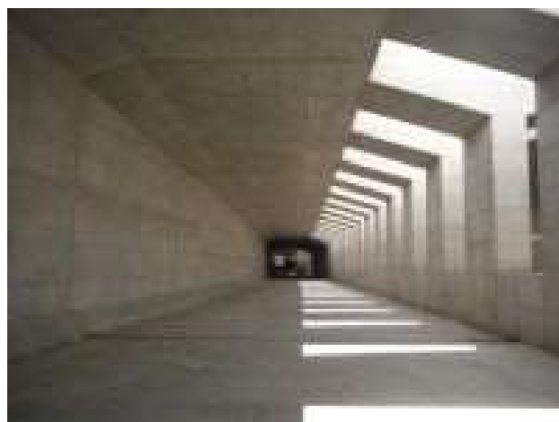
写真-2 矢切函渠その9工事竣工状況
