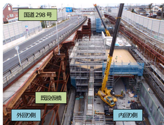
写真-1 矢切函渠その9工事内回り側施工状況
