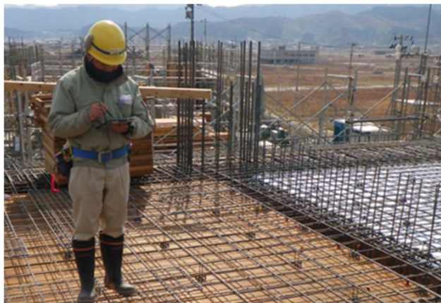
写真-1 配筋検査システム活用状況
