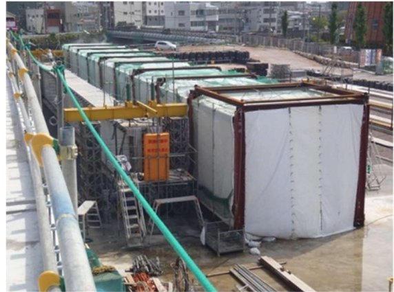
写真-1 PC 桁の養生設備外観
