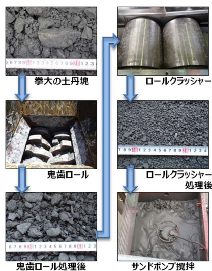
写真-2 土丹塊の解泥・溶解状況
