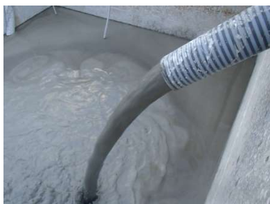
写真-9 浄化処理泥水(磁選処理工程)
