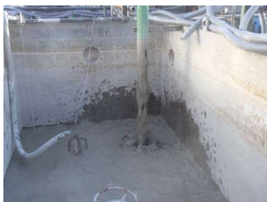
写真-8 浄化処理泥水(サイクロン処理工程)
