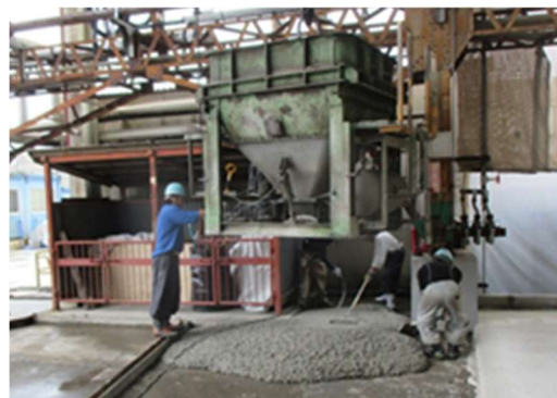
写真-2 バケットによる打込み状況
