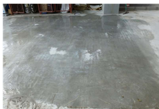
写真-3 養生完了後の仕上げ状況
