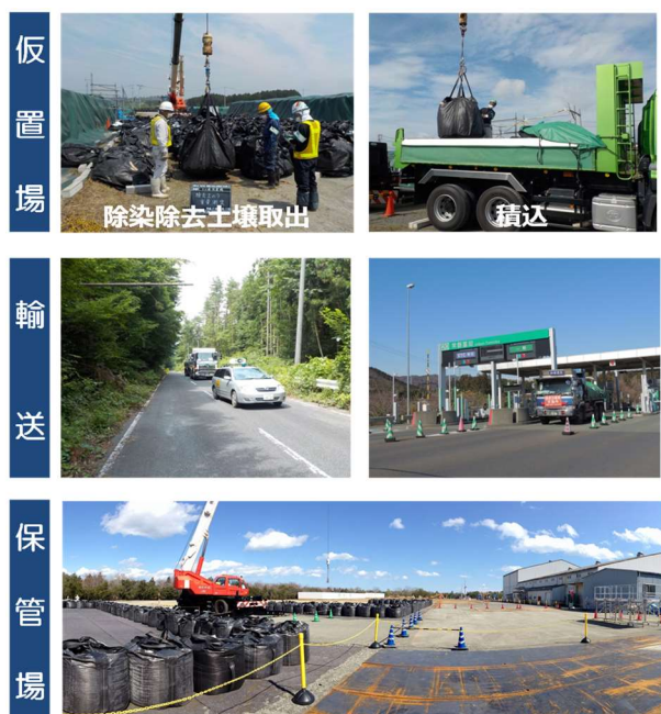
図-4 パイロット輸送実施状況
