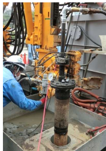
写真-3 ケーシング内の圧気作業
