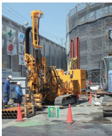
写真-1 ケーソン横の調査ボーリング
