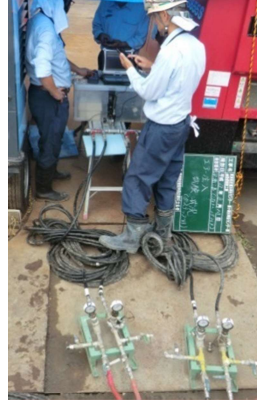
写真-10 空気注入操作
