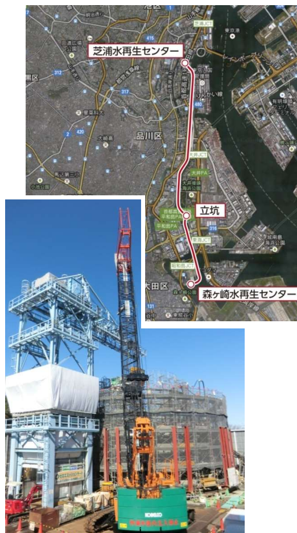
写真-1 ケーソン位置と施工全景
