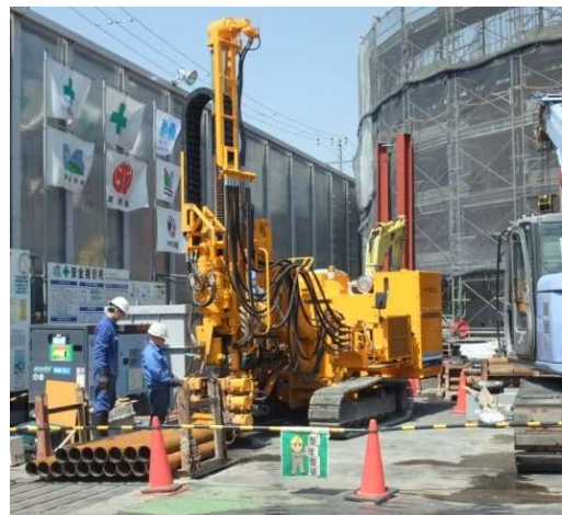
写真-2 ボーリング調査全景
