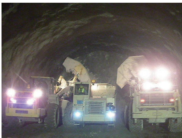
写真-2 すり出し 2 台施工状況
