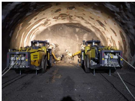
写真-10 釜石側工区ドリルジャンボ（全自動フルコンピュータジャンボ）
