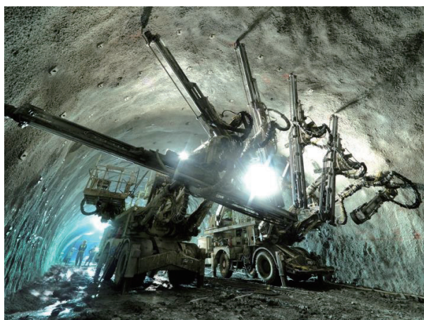
写真-1 ロックボルト 2 台施工状況
