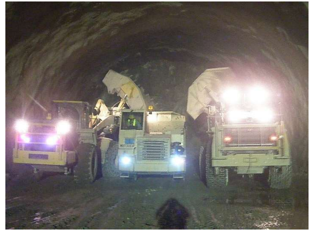
写真-4 高速ずり出し (2 台積み込み)
