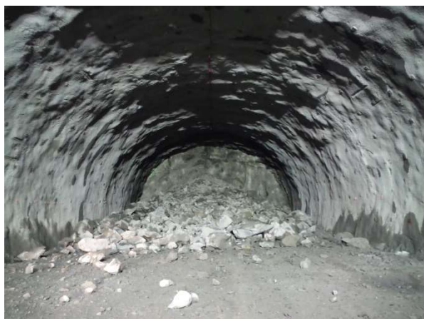
写真-18 岩塊飛散状況 (e-Dev II 25ms 全孔段発破時)
