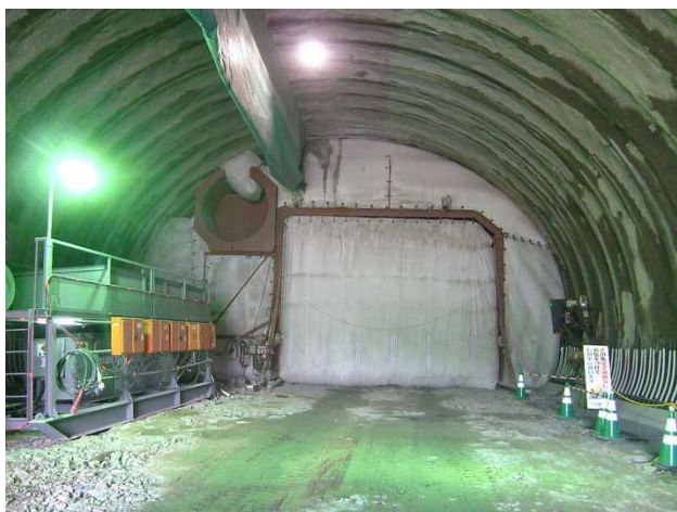
写真-12 マルチバルーン (飛び石防護時)
