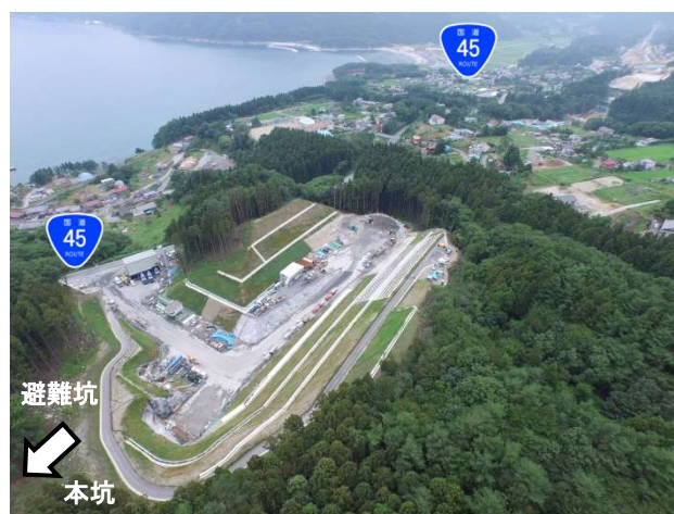
写真-1 坑口周辺環境（大船渡側坑口）
