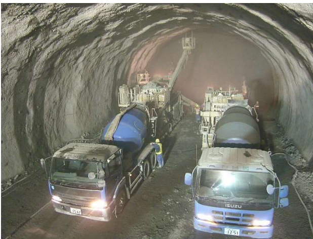
写真-5 吹付け時間短縮 (2 台吹付け)
