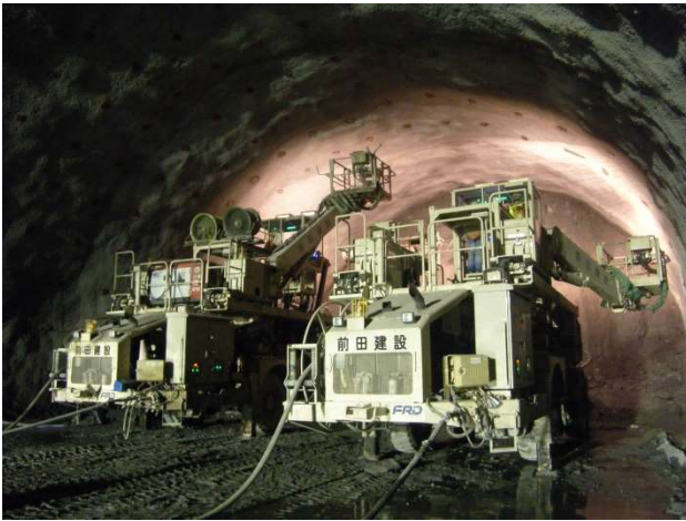
写真-3 穿孔速度向上 (2 台穿孔)
