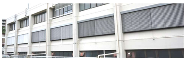
写真-1 対象室の外観（外部ブラインド巻き下ろし状態）
