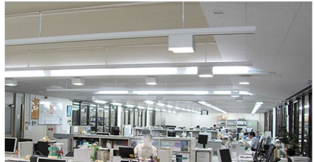
写真-3 傾斜折上げ天井部の内観（エリア2、3）
