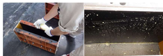
(左)噴霧時 (右)噴霧後完了後の拭き取り前 写真-8 ダイズ油系剥離剤の塗布状況
