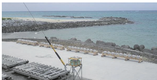
写真-1 暴露試験状況
