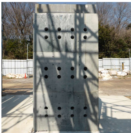
写真-4 コアボーリング後の GP 試験体状況 (GP①側)
