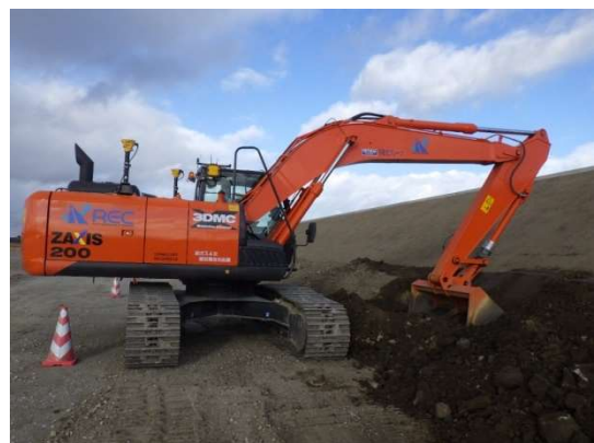
写真-6 保護盛土の法面再整形
