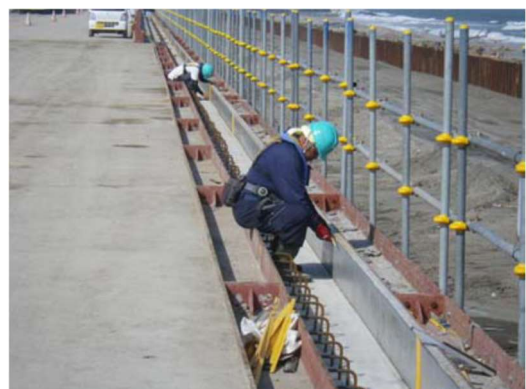
写真-5 鋼製型枠設置状況
