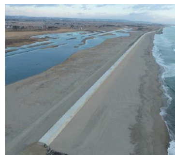
写真-2 完成写真
