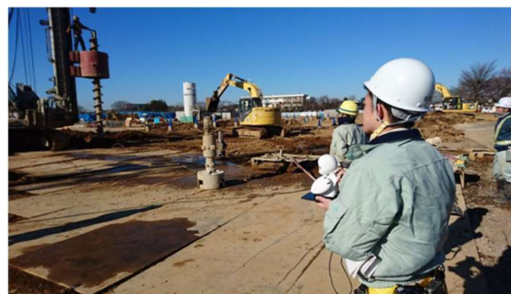
写真-2 掘削作業場付近での音声通話
