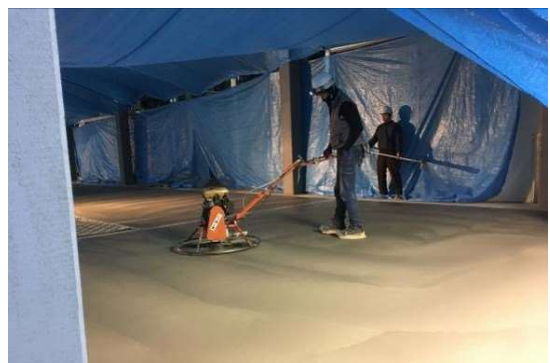
写真-5 コンクリートの仕上げ状況
