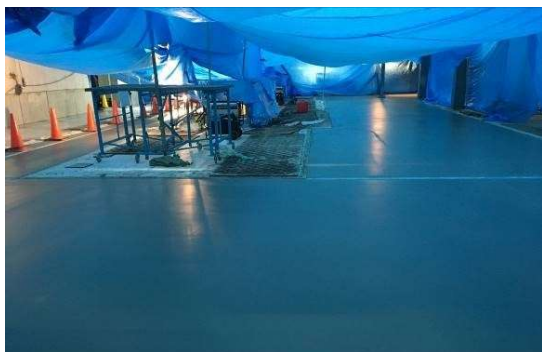
写真-6 コンクリートの仕上げ完了状況
