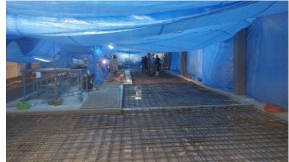
写真-2 コンクリート打込み箇所
