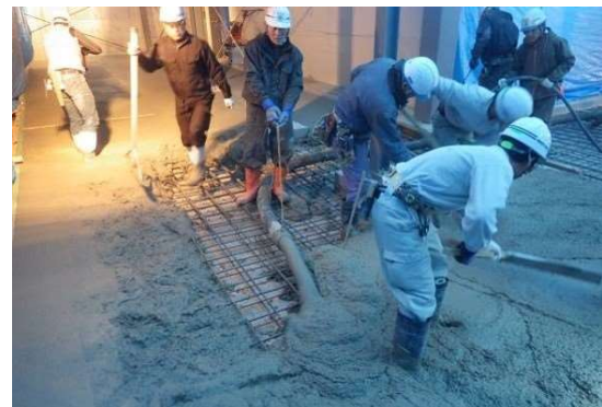
写真-4 コンクリートの施工状況
