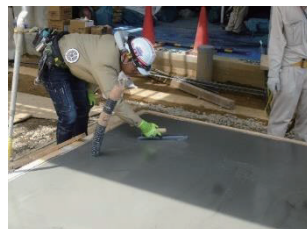
写真-1 ジオポリマー施工状況（左から、スランプフロー状況、打込み状況、押さえ状況、打込み完了状況）
