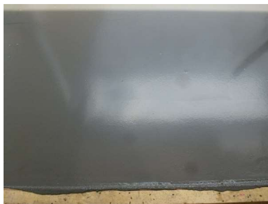
写真-6 ジオポリマー仕上げ打込み完了後の表面状態
