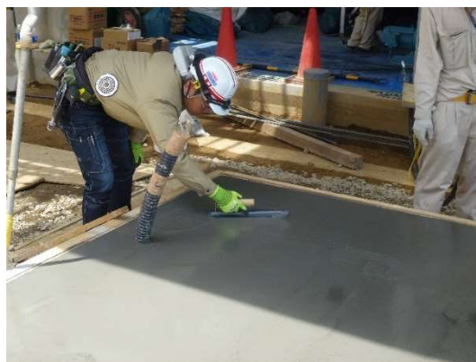
写真-4 ジオポリマー押さえ状況
