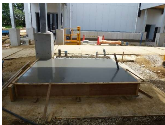
写真-5 ジオポリマー仕上げ完了状況
