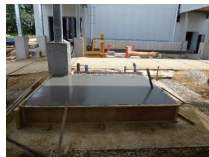
写真-1 ジオポリマー施工状況（左から、スランプフロー状況、打込み状況、押さえ状況、打込み完了状況）
