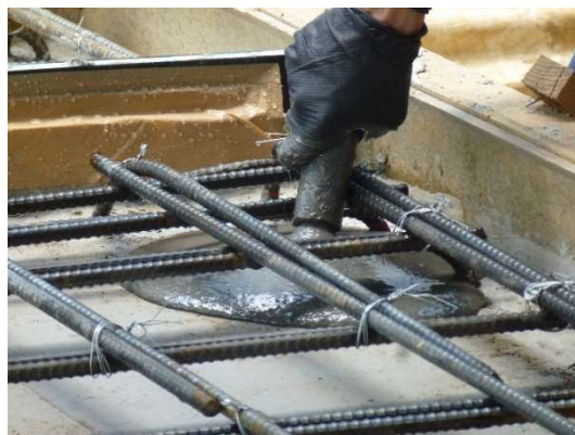
写真-3 ジオポリマー打込み状況
