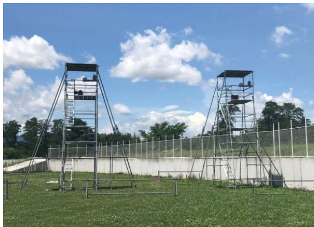
写真-10 自動追尾測量機架台設置状況
