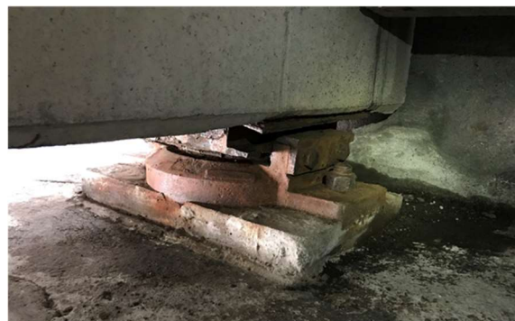
写真-1 橋梁における鋼製の支承の例
