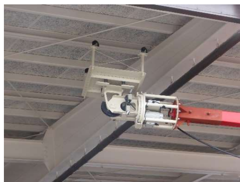
写真-2 アタッチメント取り付け状況
