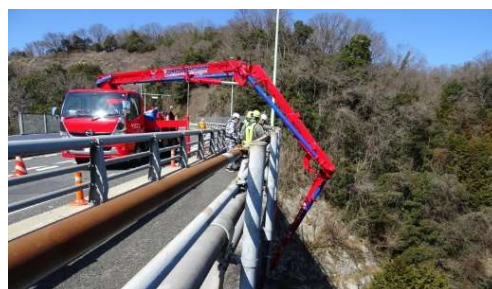
写真-3 ブームの操作状況（橋梁上部）
