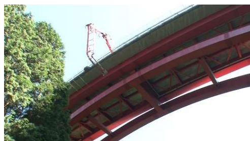
写真-4 ブーム先端の取り回し状況
