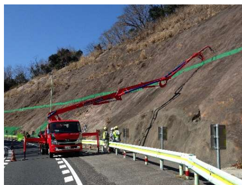
写真-6 法面への適用状況
