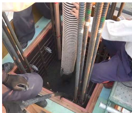
コンクリートの打込み部
