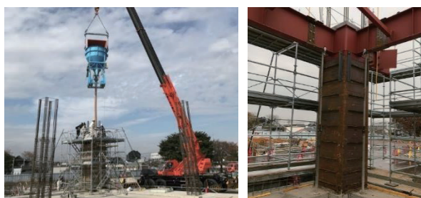
図-3 柱の施工状況
