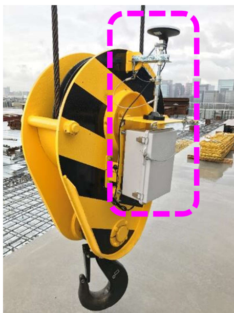
写真-3 タワークレーンフック部分の GNSS
