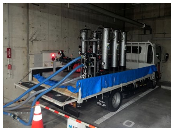
写真-4.1.2 浄化装置設置状況(トラック上で稼働)
