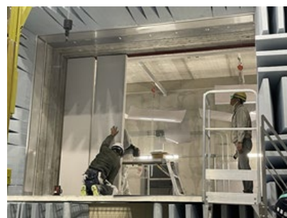
ALC パネルの建て込み
