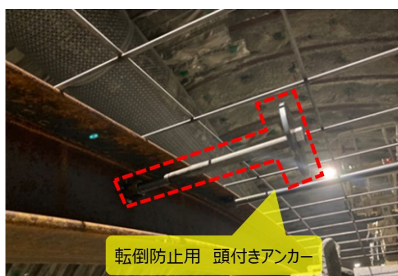
写真-6 支保工の転倒防止
