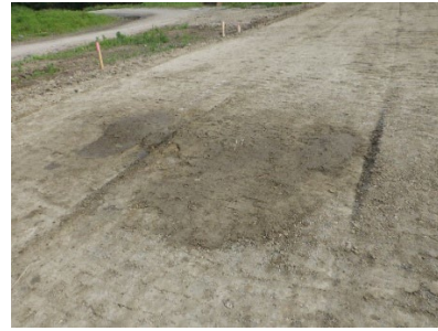
図-16 試験施工時の高含水比箇所
