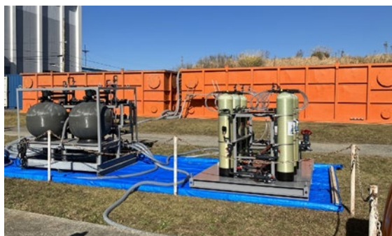
写真-4.2 浄化装置設置状況
