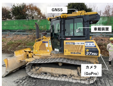
写真-4 使用した撒き出し用ブルドーザ
