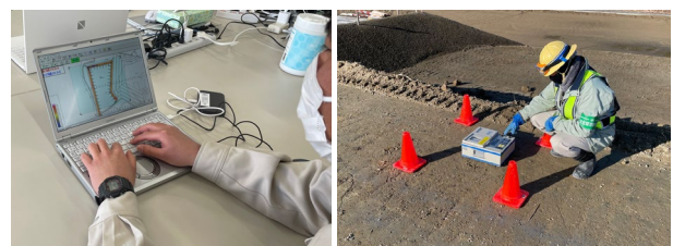
① 現場事務所における乱れ率の確認 ② 相対的弱部における現地RI計測
