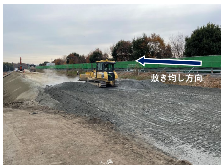
写真-6 敷き均し作業状況
