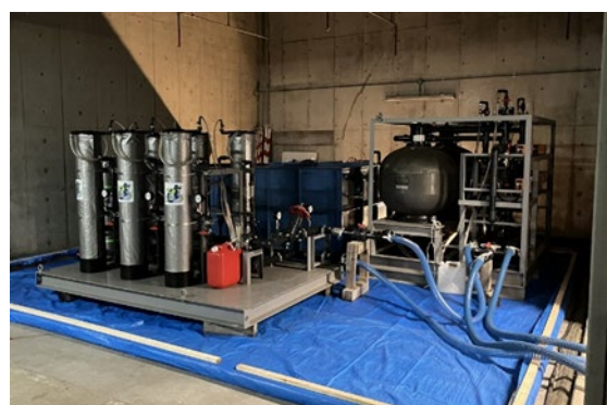
写真-4.1.1 浄化装置設置状況
