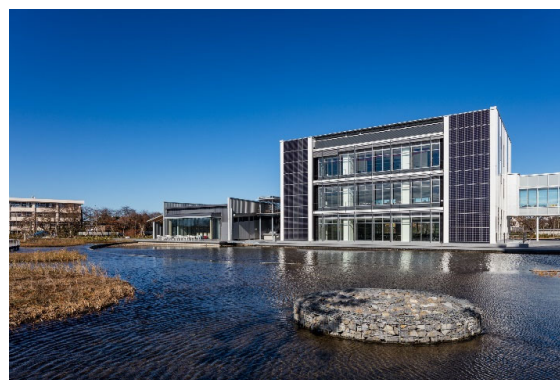
図-2 エクスチェンジ棟外観（南面）
