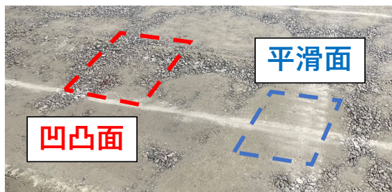
写真-2 砕石転圧面の状況 14)
