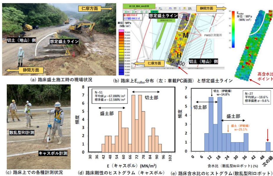
図-38 路床剛性 E_{roller} 分布および諸物性の現地計測結果 (静間仁摩工区)
