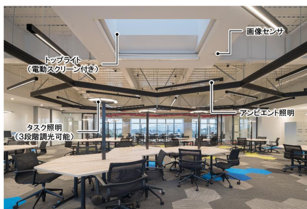
図-24 タスク&アンビエント照明 (3 階)
