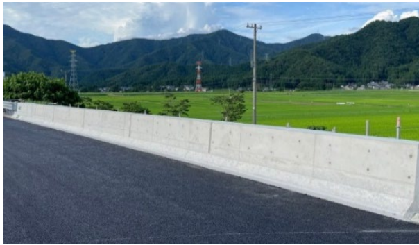
写真-5.2 コンクリート製防護柵の完成状況
