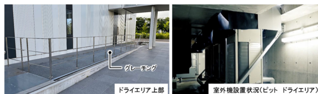
図-20 免震ピットへの室外機設置状況
