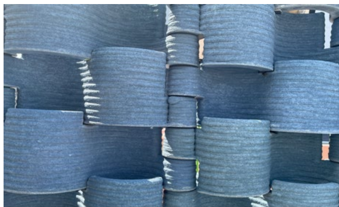
写真-4 材齢 9 か月が経過した 3DCP 壁の近影
