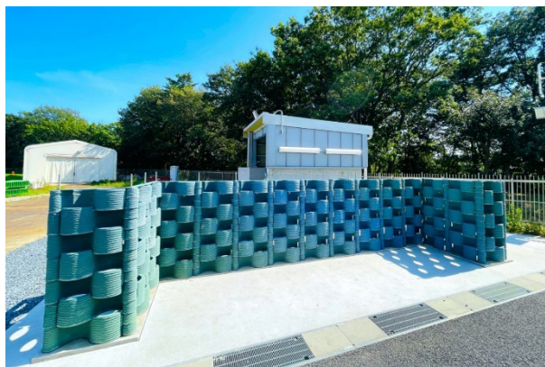
写真-3 顔料を用いたグラデーションを有する 3DCP 壁
