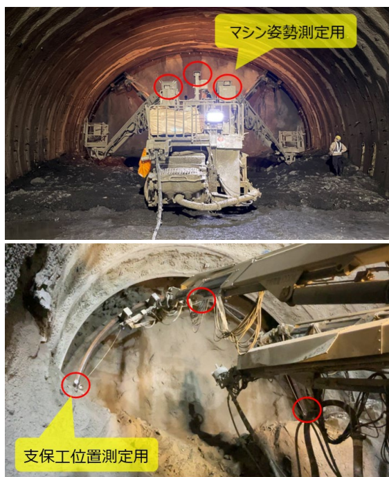
写真-1 支保工位置追尾システムのミラー設置位置
