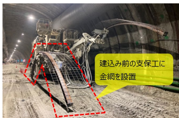
写真-5 金網の設置
