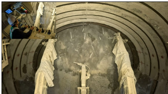
写真-11 支保工 切羽へ誘導（手動）
