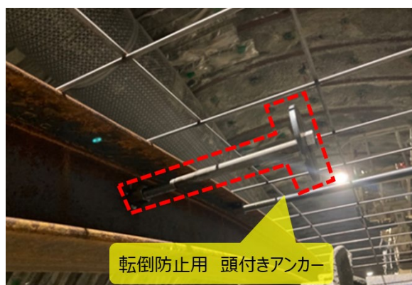
写真-6 支保工の転倒防止
