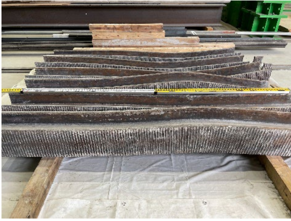
写真-1 主鋼材の基部より上の変形状況
