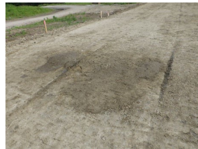
図-16 試験施工時の高含水比箇所
