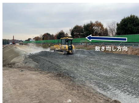
写真-6 敷き均し作業状況
