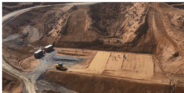
図-45 国土交通省 PRISM 大石龍門実証実験ヤード全景
