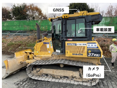
写真-4 使用した撒き出し用ブルドーザ
