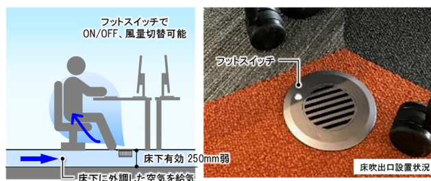
図-13 タスク空調用小型床吹出口（3 階）
