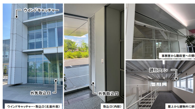
図-3 各所の自然換気窓
