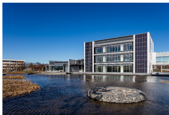
図-2 エクスチェンジ棟外観（南面）
