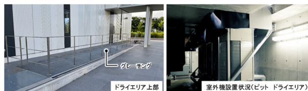
図-20 免震ピットへの室外機設置状況
