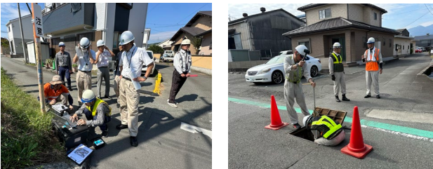
軌道横断箇所での調査 打音による音響圧力波発生 図-22 ePulse 実証風景 (F市 K水系)
