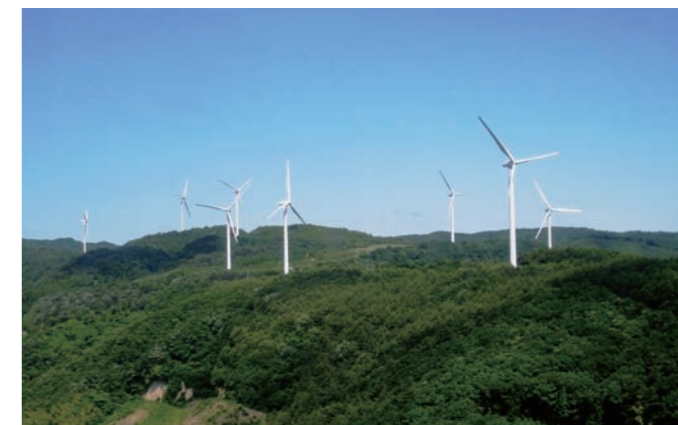
珠洲風力発電所(石川県珠洲市)
