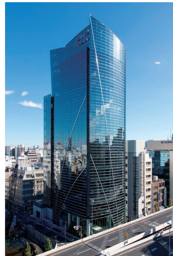
株式会社平和本社ビル(東京都台東区) 当社設計・施工による(株)平和の新社屋ビル。上野周辺のシンボルタワーとなるよう、ダブルスキンカーテンウォールを採用した先鋭的なデザインとなっている。16階建て、延床面積8,722㎡
