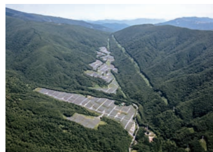
五葉山太陽光発電所
