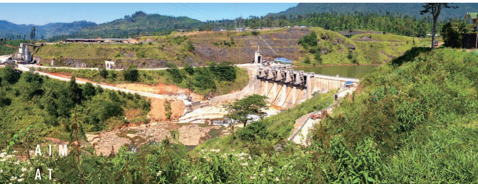
アッパーコトマレ水力発電所(スリランカ)
