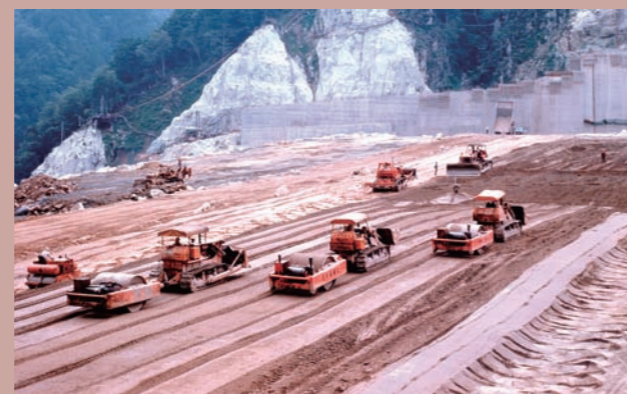
40t級ブルドーザー24台、9.2 \text{m}^2 タイヤローダー14台のほか、締固め機械やクレーン、ミキサー車などの重機械が投入された。
