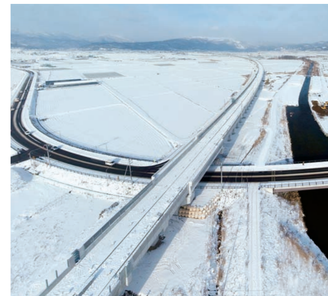
北海道新幹線 飯田高架橋(北海道北斗市)
