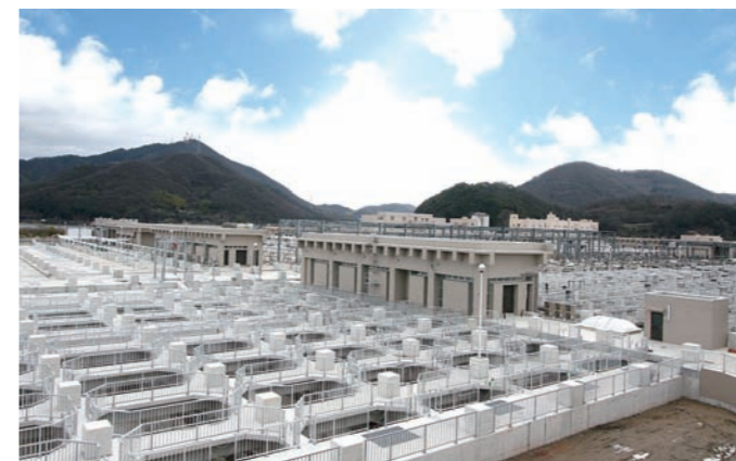
児島湖流域下水道浄化センター(岡山県玉野市)
