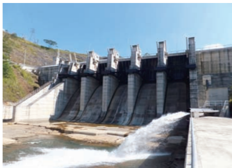
アッパーコトマレ水力発電所(スリランカ)
