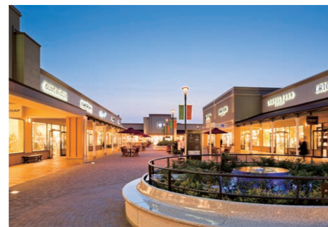
酒々井プレミアム・アウトレット(千葉県酒々井市) プレミアム・アウトレットシリーズ9店舗目となる大型商業施設。約200,000㎡という広大な敷地に、約10店舗のテナントが入る大小15棟の建物と4,700台収容の駐車場を、約10か月という短期間で施工した。
