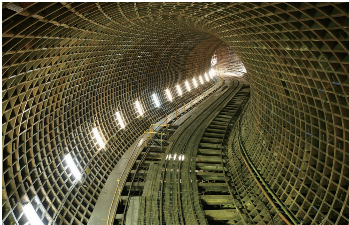
勝島ポンプ所流入管渠(東京都品川区)
