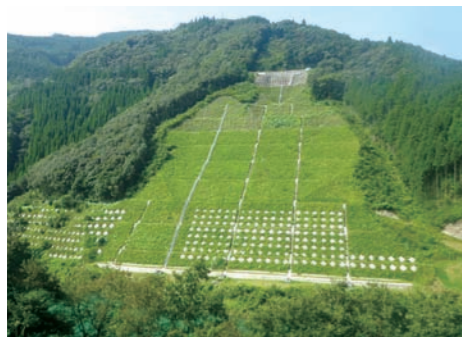
山須原発電所調整池内崩壊斜面災害復旧(宮崎県)
