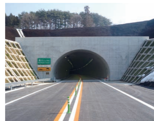
八戸環状道路 是川トンネル(青森県八戸市)
