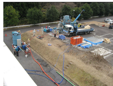
実規模圧送実験 (500m)
