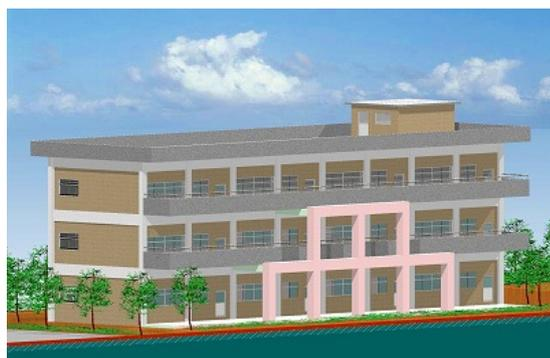
図-1 増設工法による補強外観例
