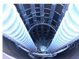
写真-2 充填コンクリート施工状況
